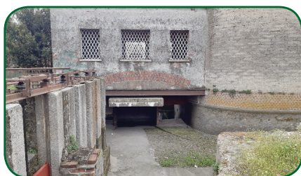
Manufatto Gregotti: come si misura l'acqua
